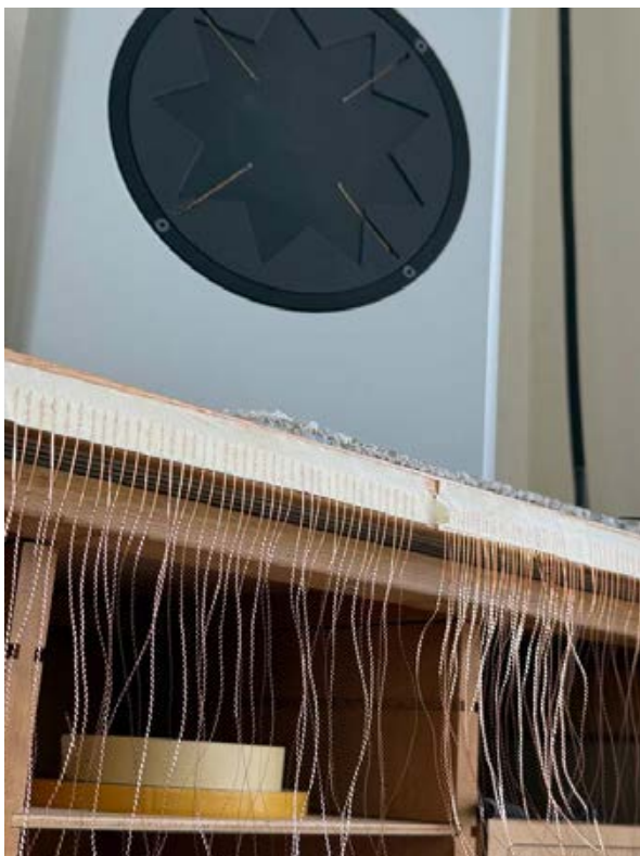
Da klebt was: Mit normalem Maler-Tape hängen die Signalleiter fertig auf Länge konfektioniert in Griffweite am Regal
